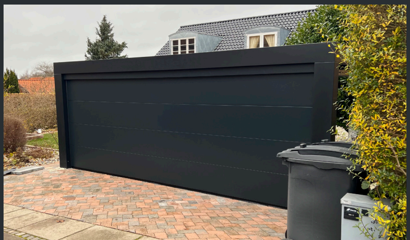
CUBUS® dobbelt carport ombygget til garage
