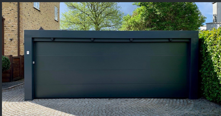
CUBUS® dobbelt carport ombygget til garage
